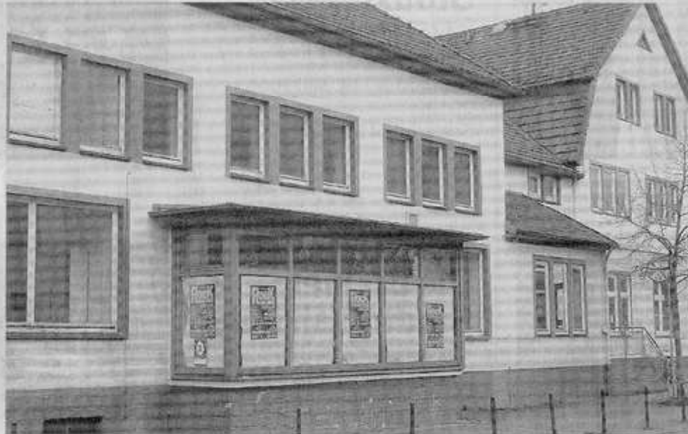
Noch wird hinter diesen Mauern renoviert, bald gerockt: Zwölf Rotenburger Bands proben demnächst im alten Bahnhof. BEC-FOTO: ANDREAS BECKER
